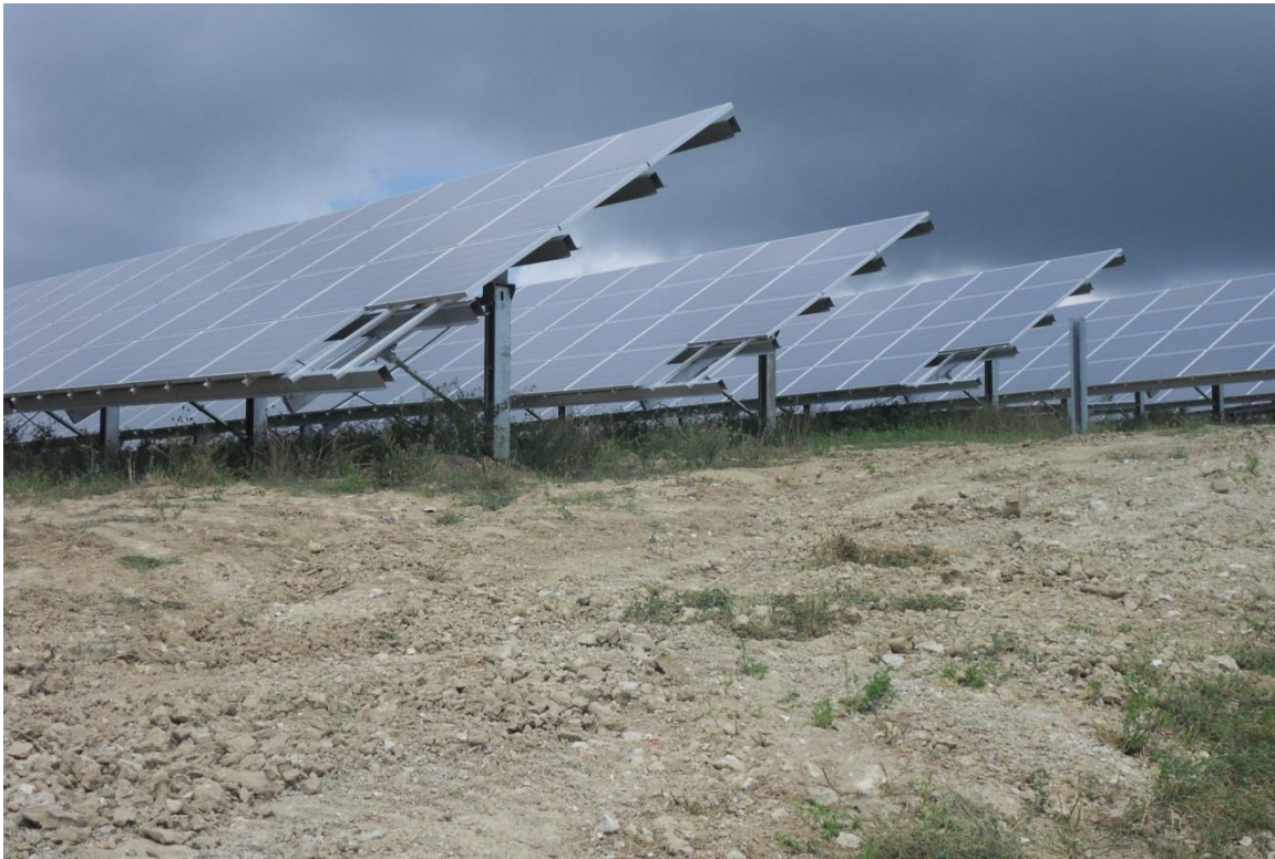
Figura 3 - 1 MWp con 4.273 moduli, 7,3 t di Al, 60 t di vetro, 3,2 t di Tedlar, 3,5 t di Si.
